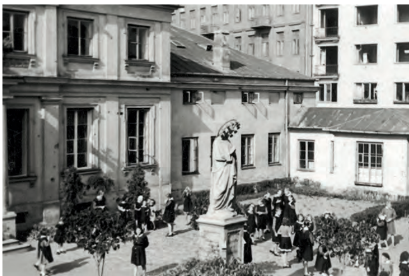
Dom główny sióstr Rodziny Maryi w Warszawie przy ul. Żelaznej 97.
